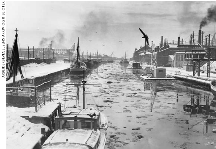
ARBEIDERBEVEGELSENS ARKIV OG BIBLIOTEK Vinterstemning fra januar 1953. Til venstre øst for elva Paulsenkaia. På vestsiden Nyland Verksted.
