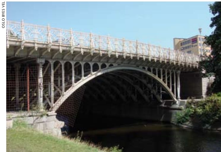
Hausmanns bru som er laget av Rodeløkkens Jernstøberi i 1892, ble utvidet 16 meter i 1986. Oslo Byes Vel har montert kulturhistorisk skilt på broen.
